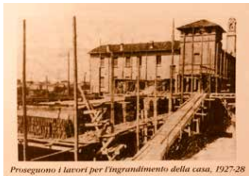
Proseguono i lavori per l'ingrandimento della casa, 1927-28
